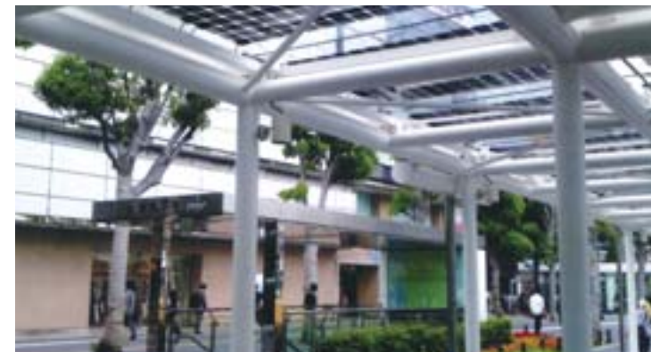
Struttura costituita da tubi in acciaio lavorati con la 3D FABRI GEAR 300
