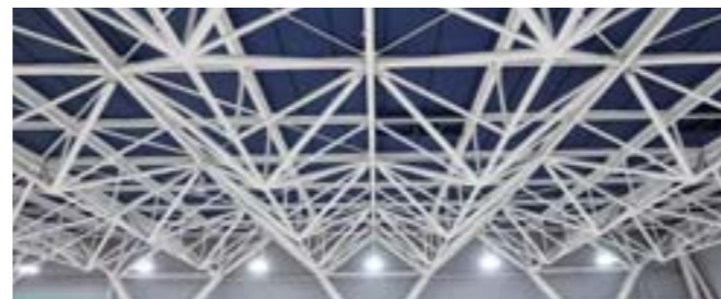
「トラス構造」を採用したヤマザキマザック美濃加茂製作所のワールドテクノロジーセンター
