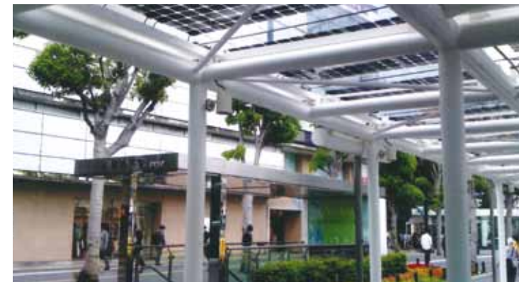
Конструкция из стальных труб, обработанных на станке лазерной резки 3D FABRI GEAR 300
