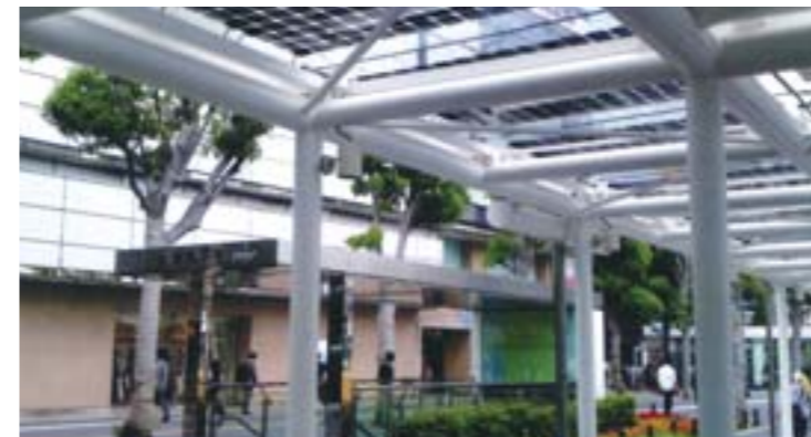
Konstruktion aus mit der 3D FABRI GEAR 300 gefertigten Stahlrohren
