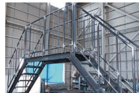
使用三维激光加工机加工的长尺寸管材和型钢焊接而成的铁楼梯
